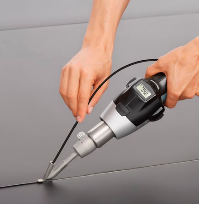
▲ Заваряване на линолеум HG 2620 E
