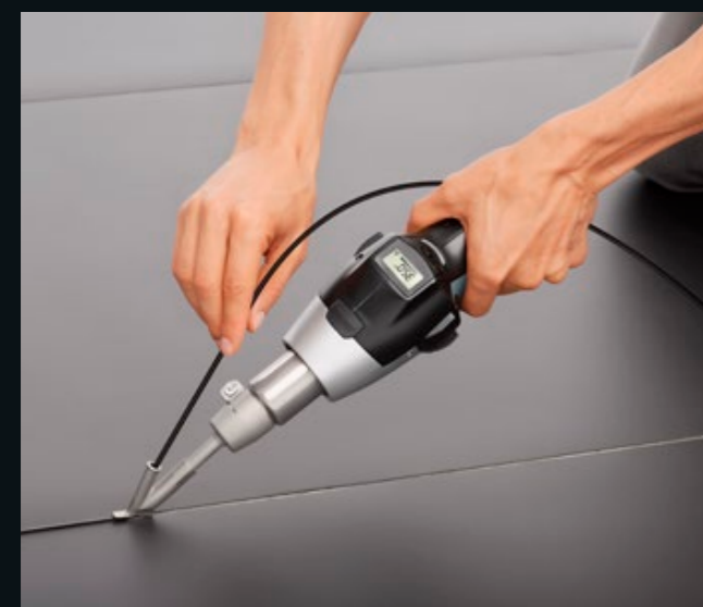
Заваряване на подове от линолеум.
