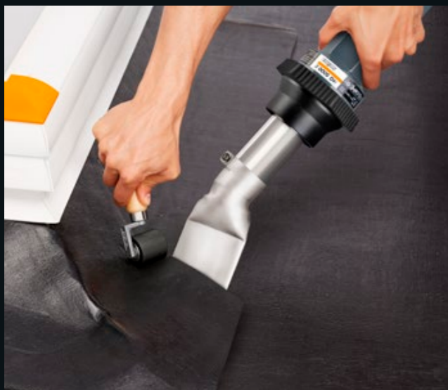
Заваряване с припокриване на светлинен купол.
