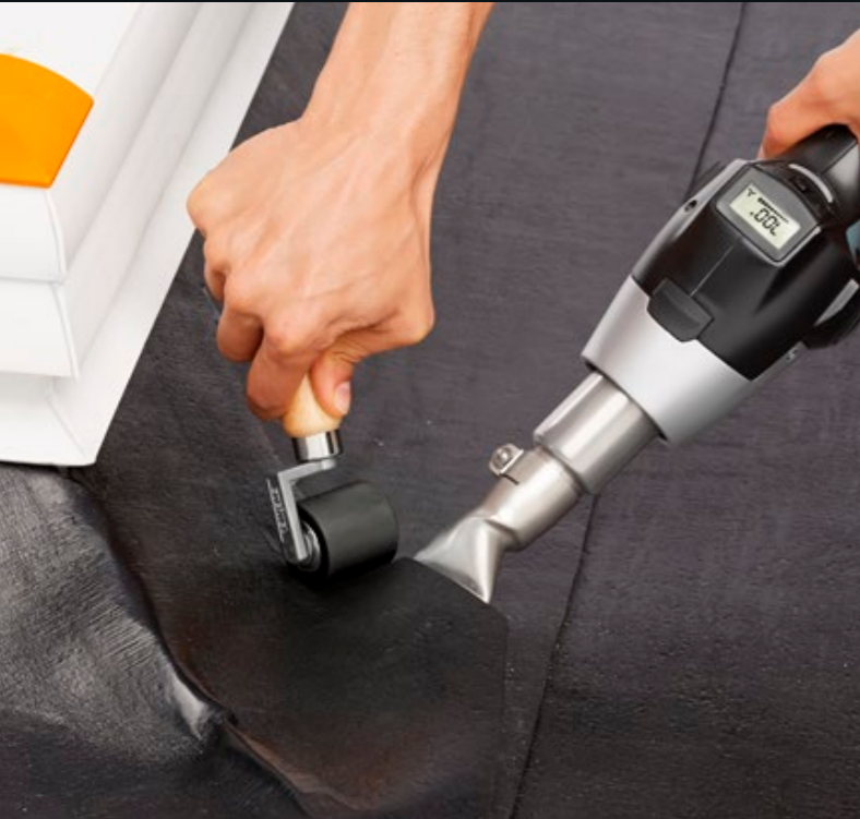
◀ Заваряване с припокриване HG 2620 E
