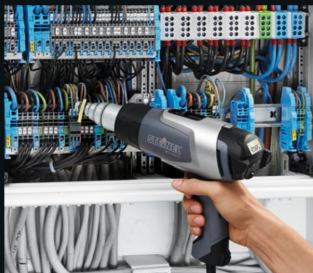
Свиване на кабели в разпределително табло.
